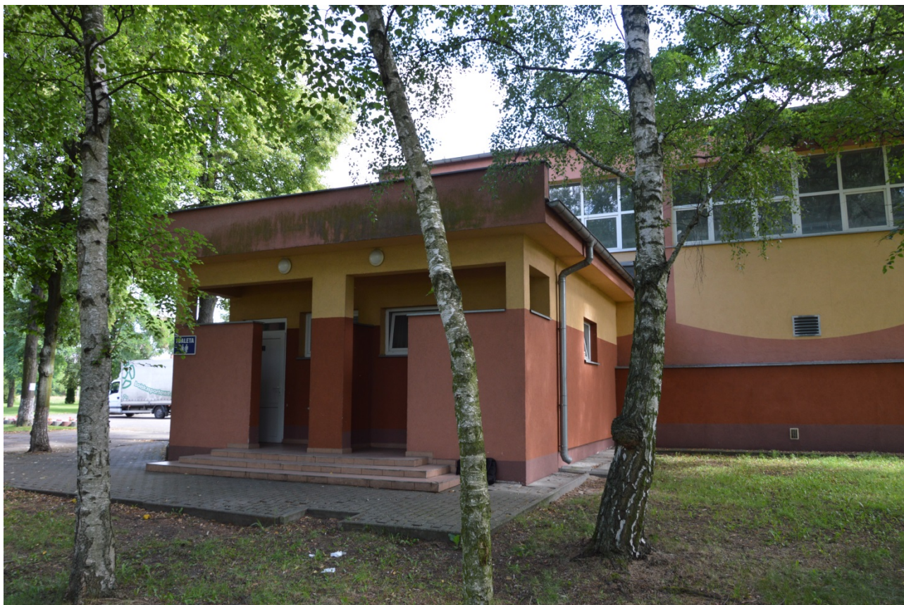
1. Widok na wejście do budynku sanitarnego.
