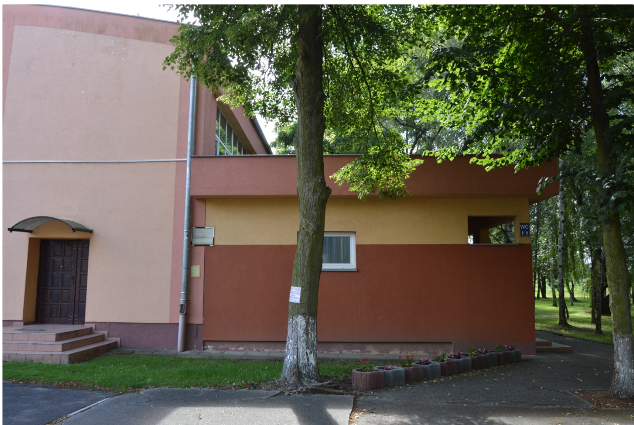
5. Elewacja boczna budynku sanitarnego, po lewej wejście na salę gimnastyczną.
