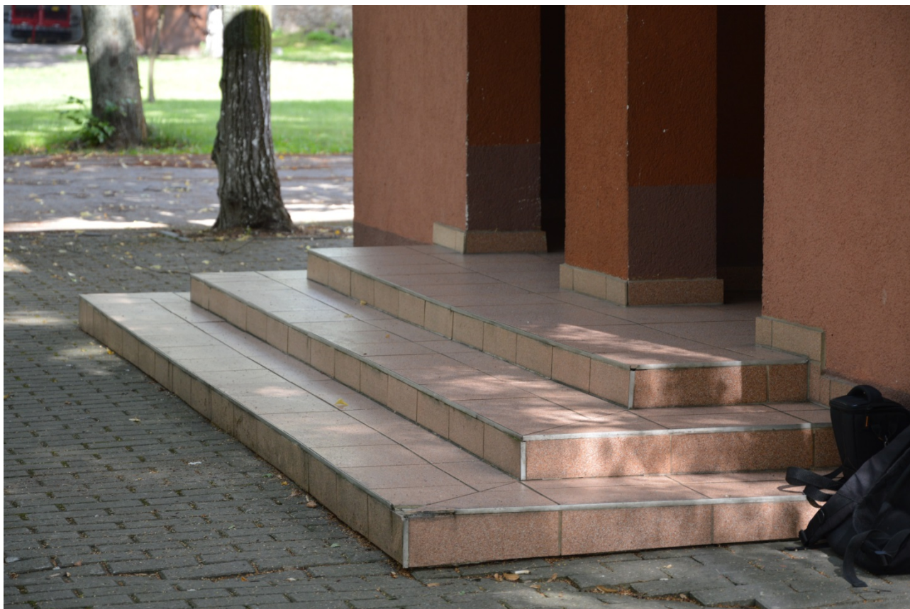
7. Schody wejściowe do budynku sanitarnego.
