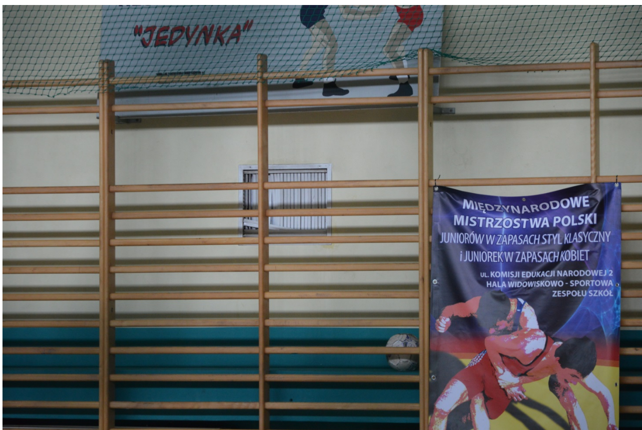
10. Wnętrze sali gimnastycznej z widokiem na nawietrzak.
