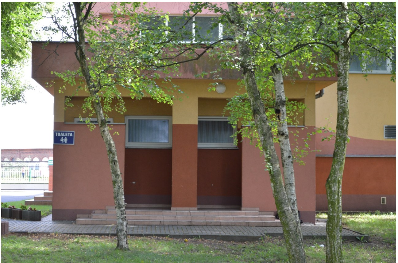
4. Elewacja wejściowa budynku sanitarnego.
