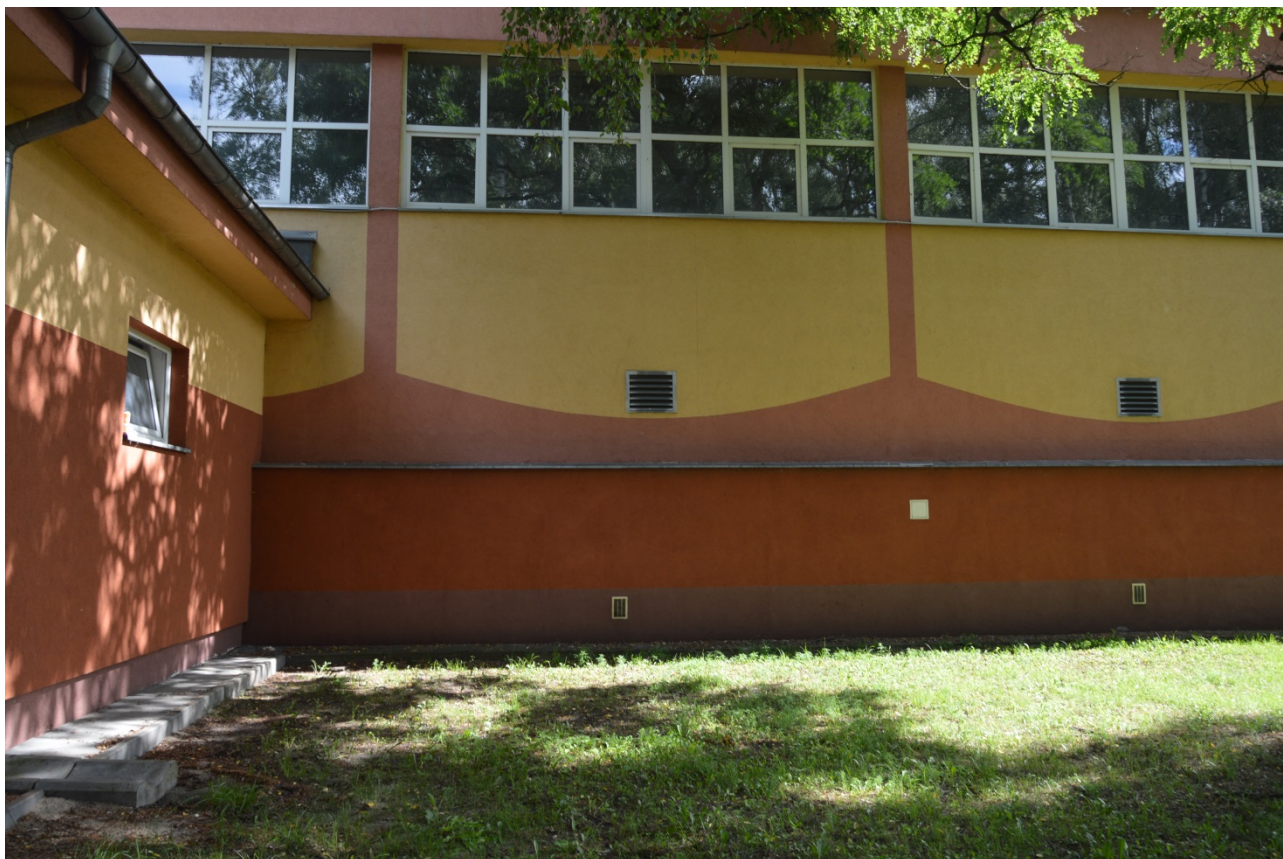
9. Teren przeznaczony pod rozbudowę sali sportowej o zespół szatniowy. Widok na okna doświetlające salę gimnastyczną i kraty nawiewne.
