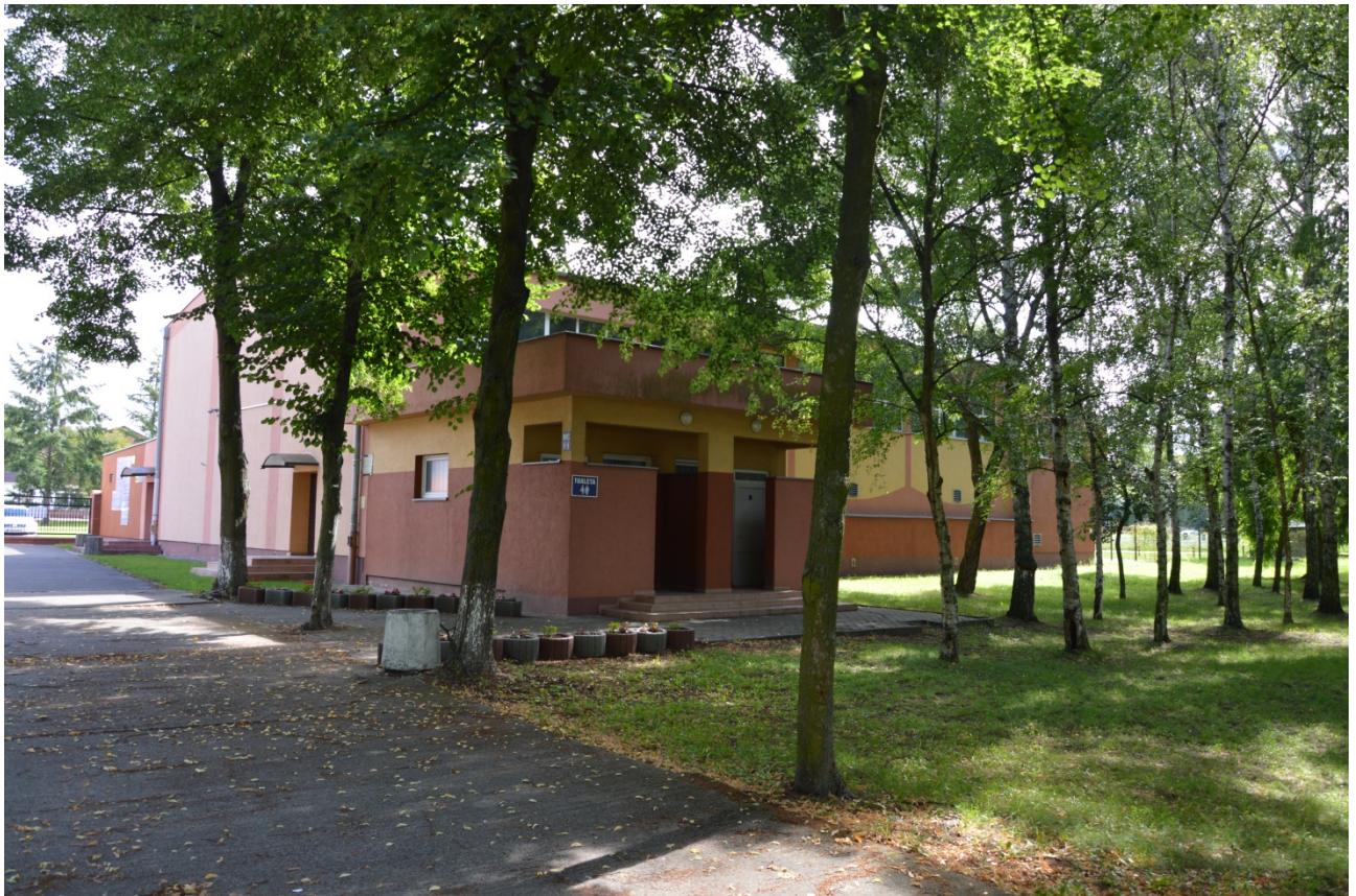
3. Widok na budynek sanitarny i salę sportową od drogi wewnętrznej.
