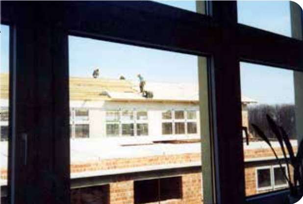
Budowa Szkoły Podstawowej Nr 3
