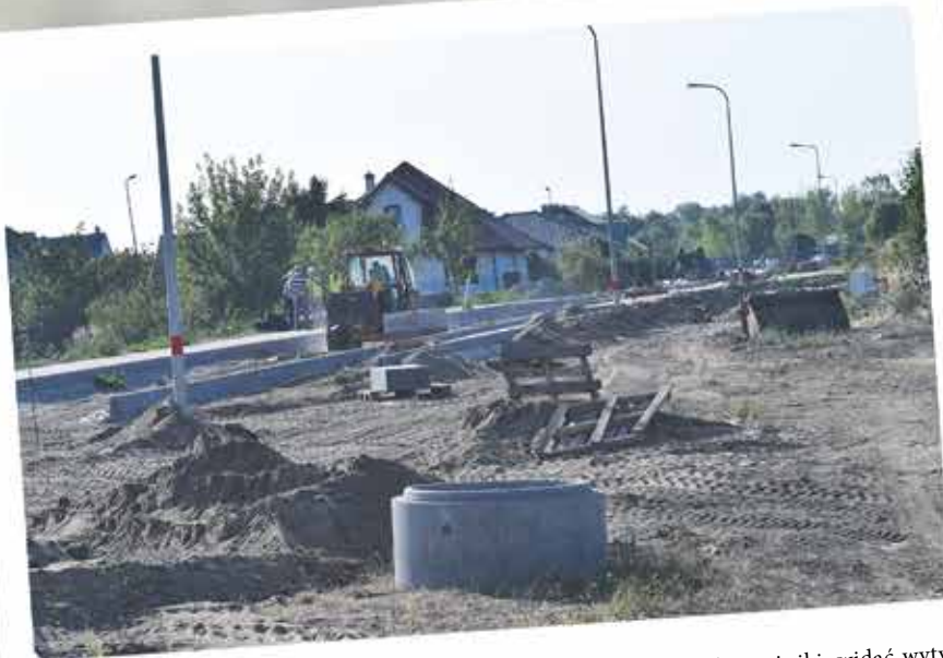
Ul. Łódzka – trwa montaż kanalizacji deszczowej, są już chodniki, krawężniki, widać wytyczony geodezyjnie zarys drogi, która tu powstanie. Przy ulicy stoją już latarnie. Inwestycja jest efektem pozytywnie rozpatrzonego wniosku budżetowego złożonego przez mieszkańców do burmistrza miasta.
