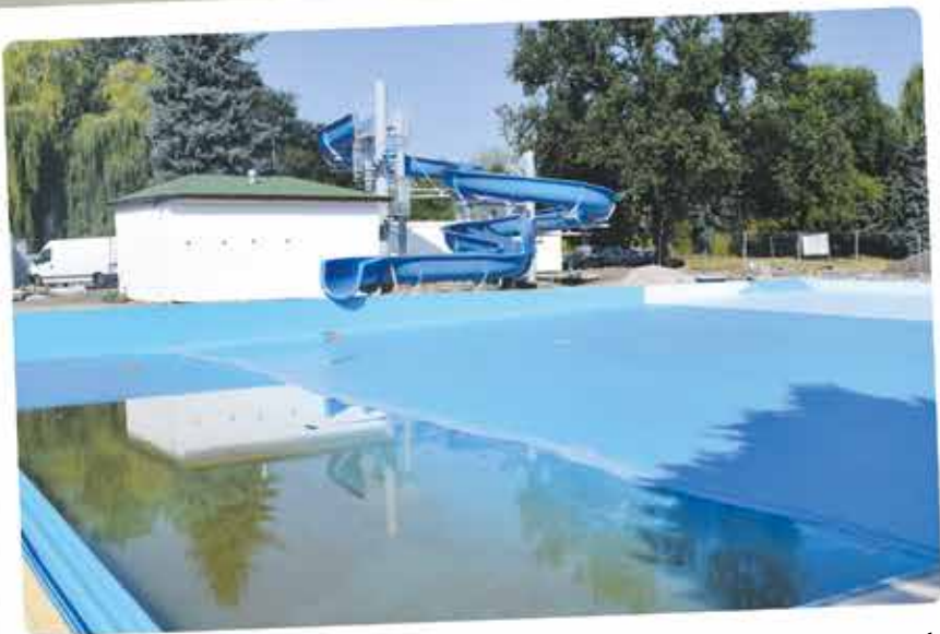
Basen „Mors” – na terenie basenu jest już zamontowana cała technologia, tj. stacja uzdatniania wody – serce inwestycji, cała niecka basenowa jest już wyłożona folią basenową, są już kontenery dla ratowników i kontener sanitarny, na wykończeniu są roboty ziemne – wyłożenie dookoła basenu kostki betonowej. Planowany remont basenu przeciągnął się, gdy okazało się, że zakres prac remontowych musi być dużo szerszy niż na początku zakładali projektanci poszczególnych branż. Basen musi być jednak przede wszystkim bezpieczny, dlatego na jego otwarcie mieszkańcy oczekują z cierpliwością. Inwestycja jest realizowana ze środków miasta z 30-tysięcznym dofinansowaniem Urzędu Marszałkowskiego.
