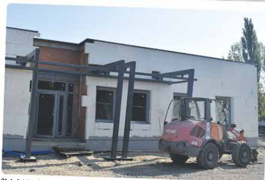
Żłobek Miejski – Mamy już stan surowy zamknięty, trwa montaż instalacji w środku, pojawiają się pierwsze płytki, rozpoczęliśmy prace związane z zagospodarowaniem terenu wokół budynku. W naszym Żłobku stworzymy miejsce dla 60 dzieci, których gwar wypełni to miejsce w pierwszym kwartale przyszłego roku. Budowa żłobka dofinansowana jest w ramach Resortowego programu rozwoju instytucji opieki nad dziećmi w wieku do lat 3 „MALUCH +” 2018 w wysokości 1 200 000 ,00 zł.
