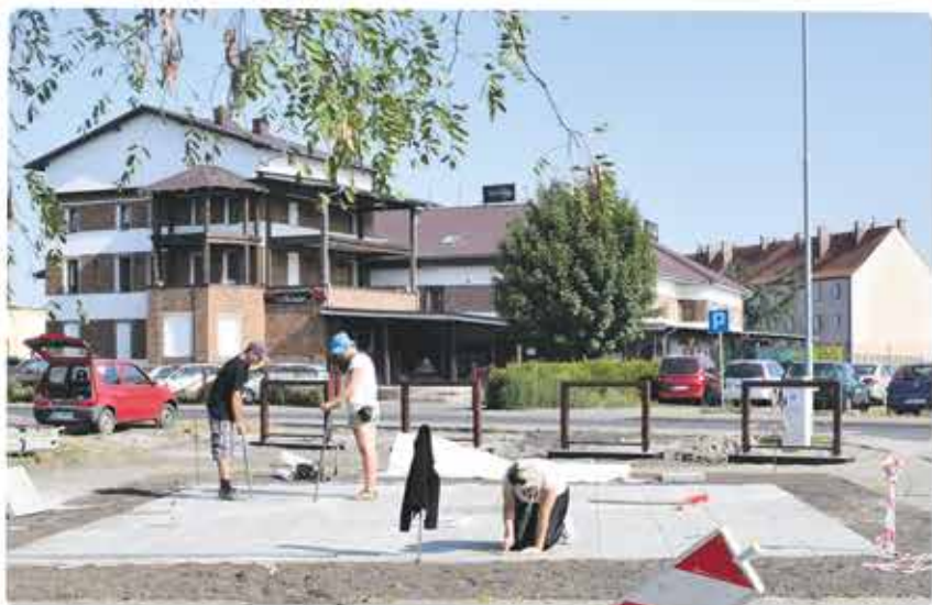
Skwer przy ul. Jana Pawła II – zamontowane zostały stelaże pod panele dekoracyjne, zakończyliśmy roboty ziemne, trwają obecnie prace budowlane. Najpiękniej będzie wyglądał na wiosnę 2019 roku. Skwer stanowi jedno z zadań zaplanowanych do zrealizowania w ramach projektu „Poprawa jakości środowiska miejskiego poprzez renowację i rozwój wybranych terenów zieleni w Gorzowie Wlkp., Kostrzynie nad Odrą i Dębnie” dofinansowanego w wysokości 665 436,69 zł ze środków Programu Operacyjnego Infrastruktura i Środowisko 2014-2018.
