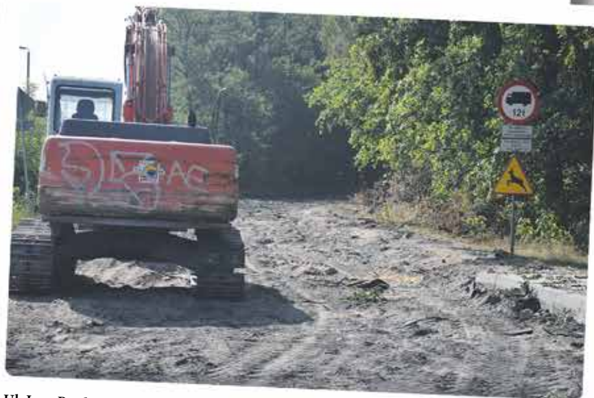
Ul. Jana Pawła II – zakończono prace rozbiórkowe starej nawierzchni asfaltowej, tworzona jest kanalizacja deszczowa, przygotowujemy się już do ułożenia koryta drogi i ułożenia krawężników. Na wykonanie tej 620 metrowej drogi „przez las” otrzymaliśmy dofinansowanie w ramach rządowego Programu na rzecz rozwoju oraz konkurencyjności regionów poprzez wsparcie lokalnej infrastruktury drogowej w wysokości 1 589 526,00 zł
