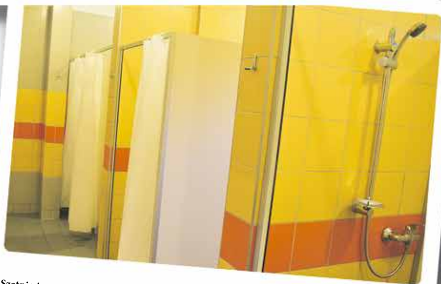
Szatnie i sanitariaty w SP4 – ukończony jest już remont sanitariatów i szatni w SP4. Na chwilę obecną trwają jeszcze prace remontowe szatni w piwnicy.
