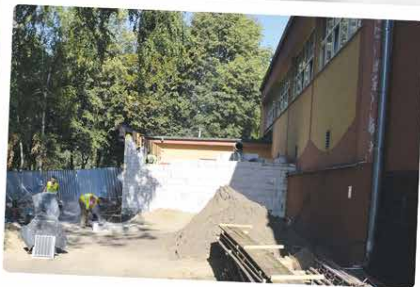
Szatnie przy MOSiR – trwają prace murarskie, są już fundamenty, ściany, a na tyłach ośrodka jest już piękna zielona murawa przygotowana pod trzy boiska treningowe.
