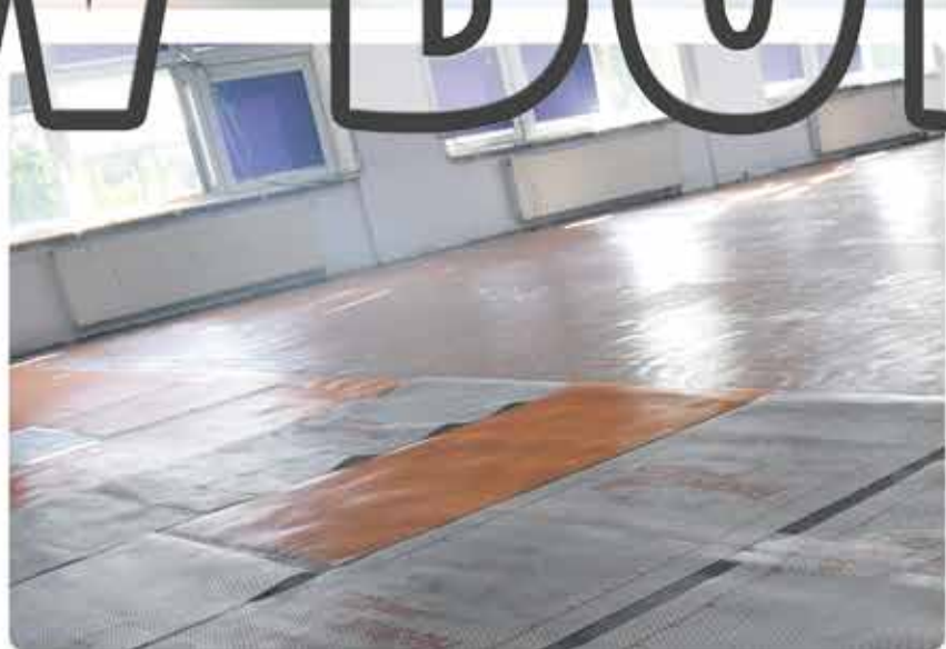
Sala Gimnastyczna przy SP3 – nie ma już starej podłogi na Sali. Trwa obecnie układanie nowej nawierzchni sportowej, wykonanej ze środków budżetu miasta dla podniesienia komfortu sportowego zajęć sportowych i bezpieczeństwa dzieci.
